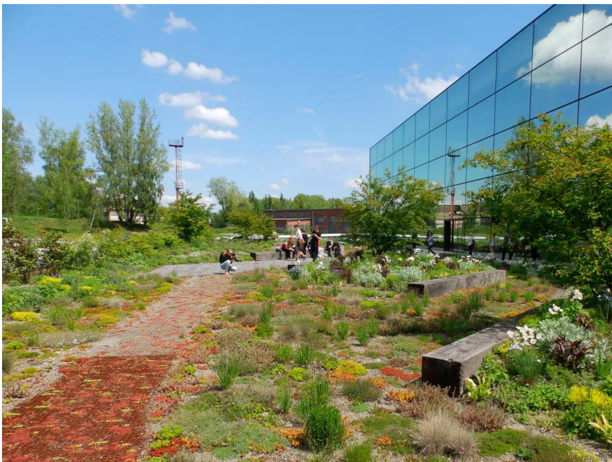
Zelená střecha u Velkého světa techniky v Dolní oblasti Vítkovice v Ostravě (1. místo v soutěži Zelená střecha roku 2016)
